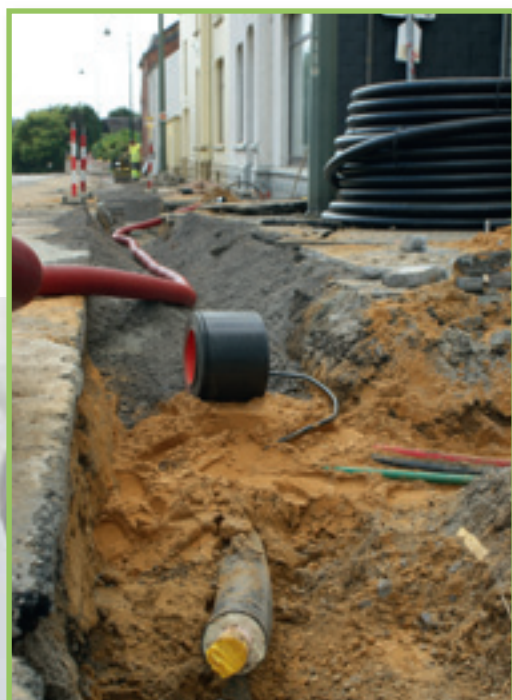
Chaudière et placement du réseau de chaleur à Libin
