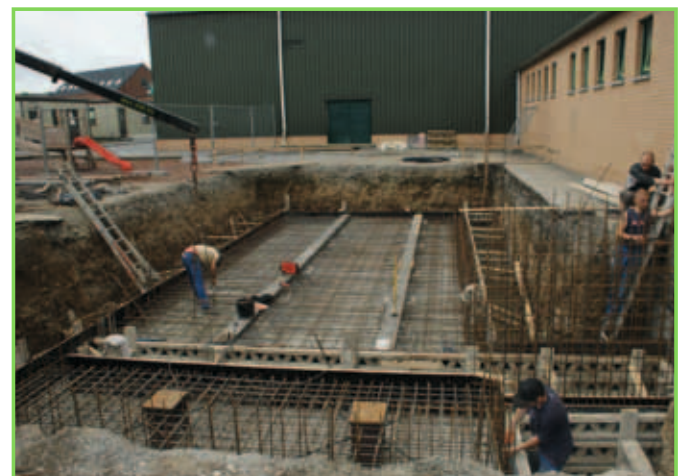
Hotton : construction du silo de stockage du combustible
