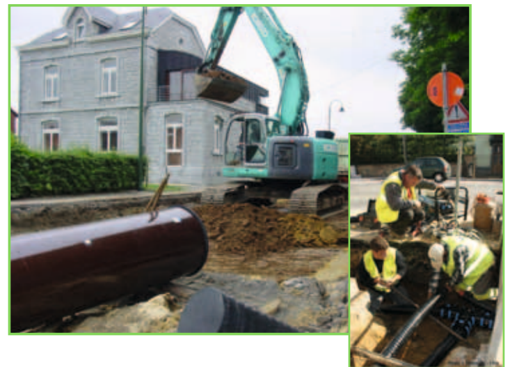
Hotton : placement du réseau de chaleur conjointement au réseau d'égouttage
