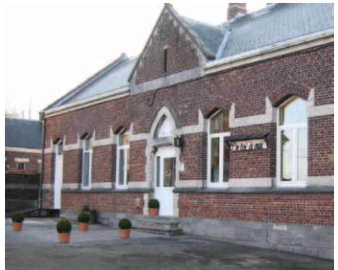
La cuisine de collectivité et le restaurant social occupent une ancienne école
