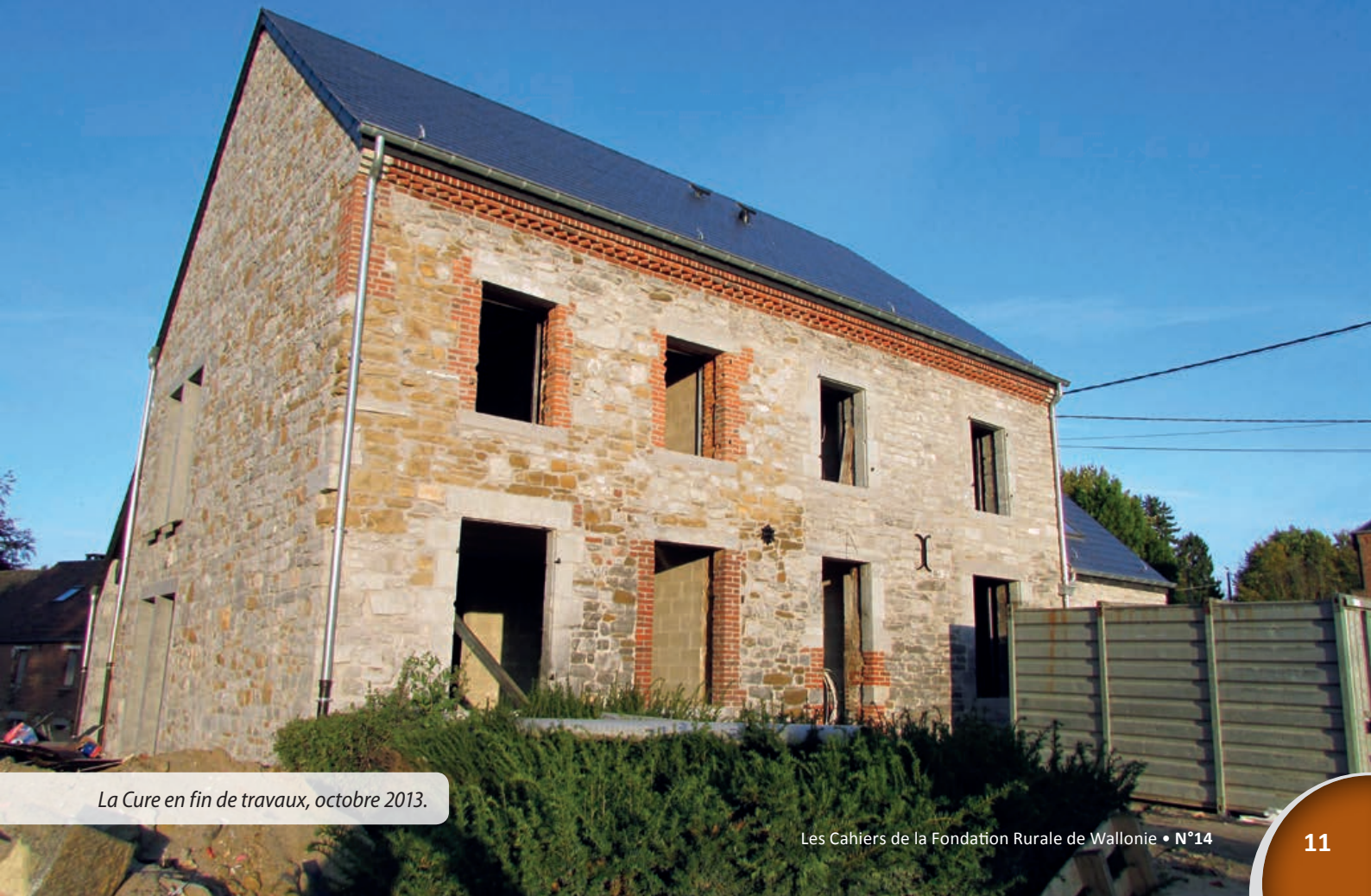
La Cure en travaux : seule la façade avant a été conservée pour faire place nette à des logements à loyer modéré et un lieu d'activité pour les jeunes.
