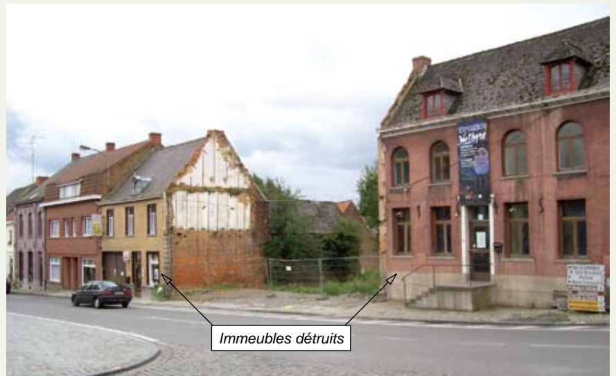
Chancre bordé de bâtiments vétustes, aujourd'hui détruits, fermant un côté de la Place d'Ellezelles avant l'implantation du complexe abritant le CACS (document Atelier d'architecture Face-7).
