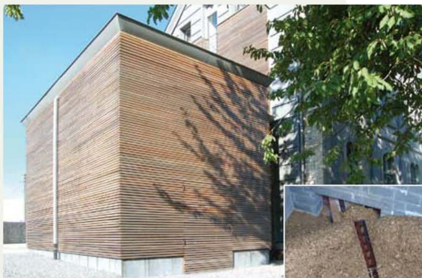
Le volume annexe comprenant le silo, accessible par le parking, et la chaufferie.
