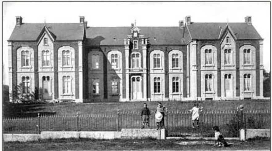
La façade principale des « anciennes écoles », inaugurées en 1871. Photo du début du 20 e siècle. © cyberlab-van den Eynde
