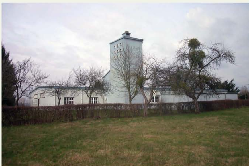
Vue extérieure de l'ancienne usine de copie de meubles anciens avant réaffectation.
