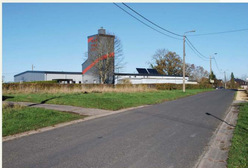
A l'avant-plan, le terrain qui devrait accueillir les logements basse énergie.
