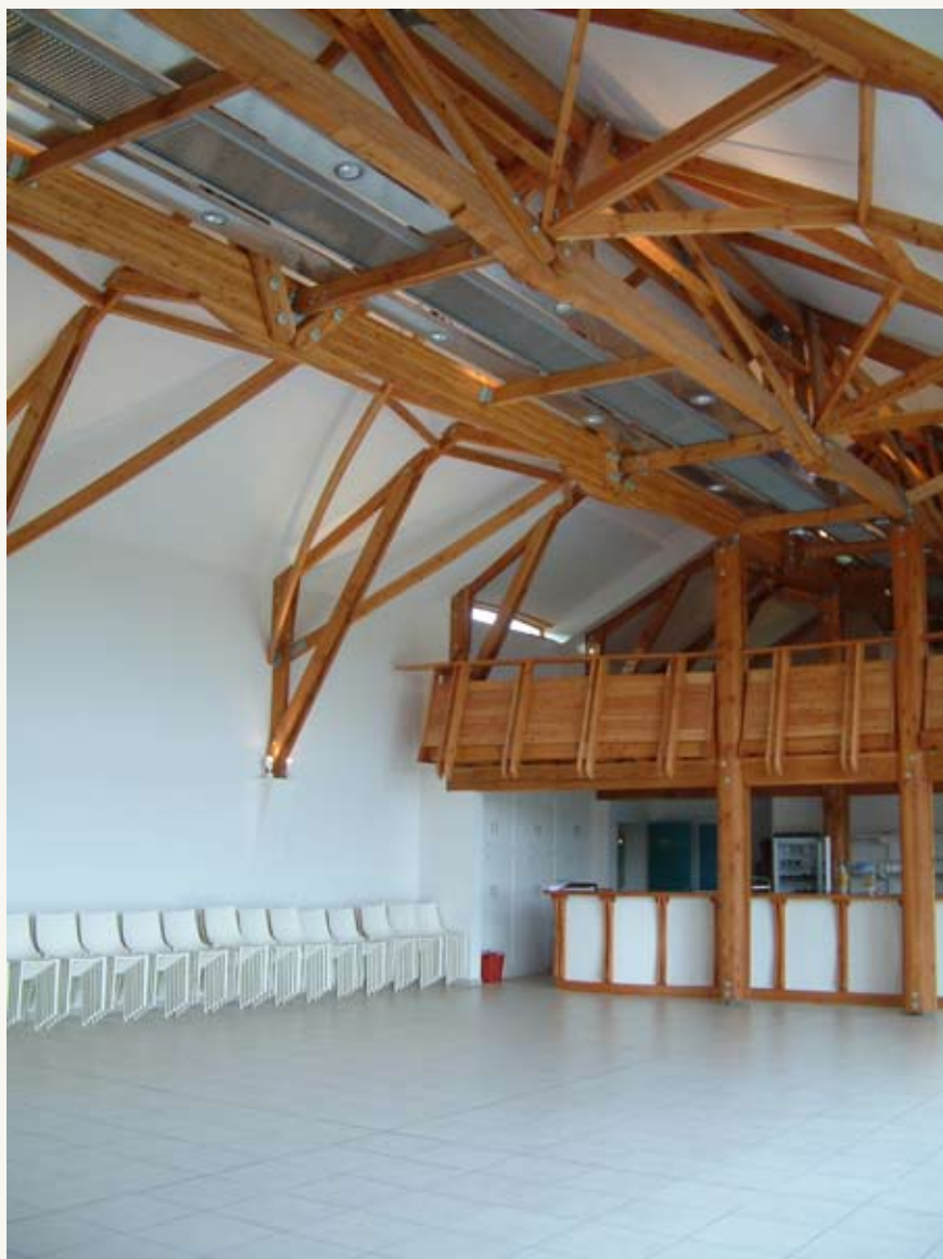
Fig. 10 : La structure de la charpente couvre l'ensemble du bâtiment et s'appuie sur les colonnes du bar.
