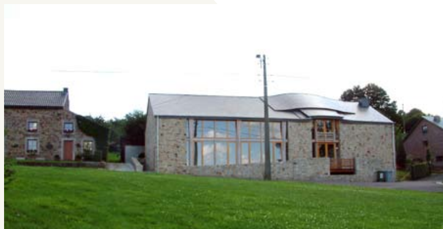
Fig. 6 : La façade principale du bâtiment
