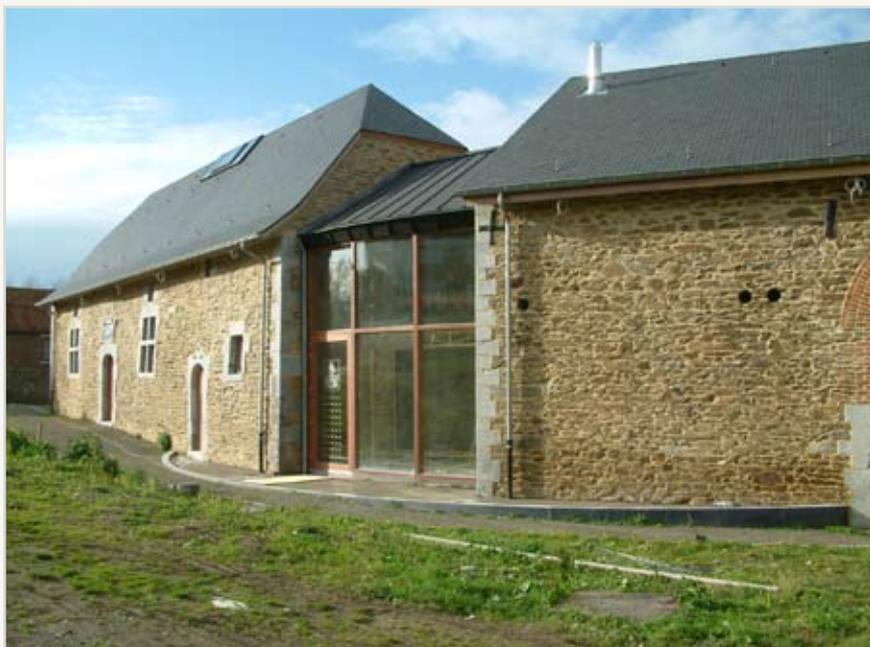
Fig. 10 : L'ancienne étable a fait place à un volume de transition entièrement vitré faisant office de zone d'accueil
