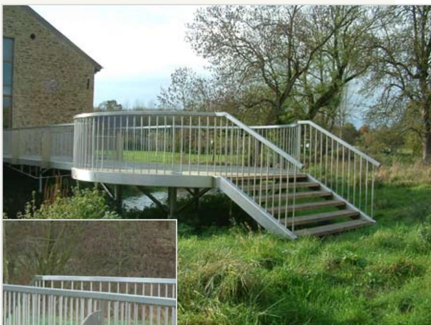
Fig. 16 et 17 : Bois et aluminium pour une passerelle alliant simplicité, élégance et soucis du détail
