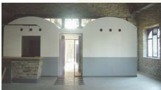
Vue sur les locaux techniques intégrés dans l'espace principal.
