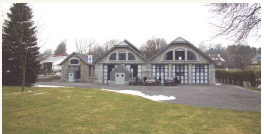
Vue des façades arrières du bâtiment.
