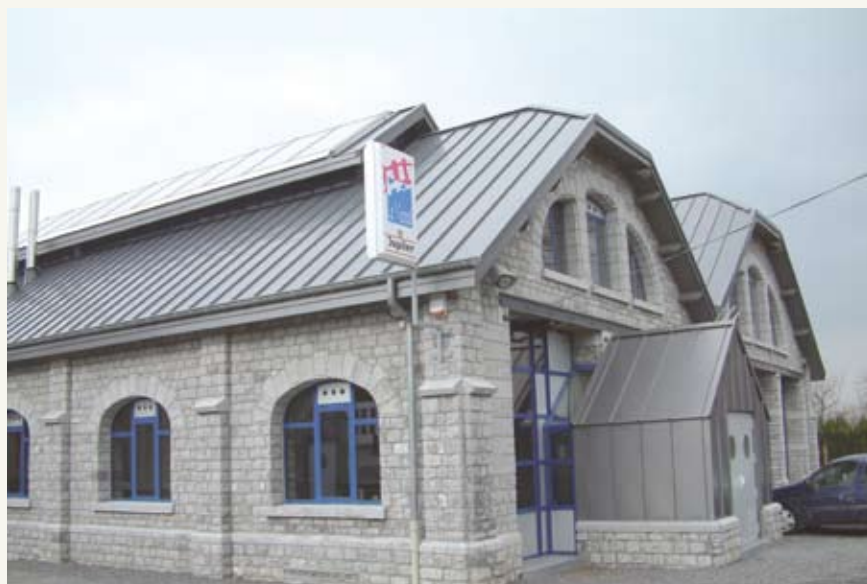
Sas d'accès aux salles polyvalentes.
