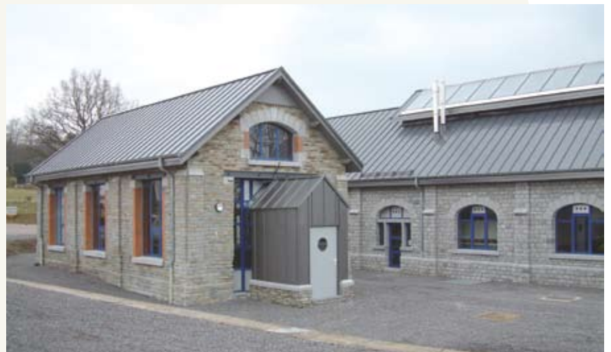
Une partie de la toiture est recouverte de panneaux solaires.
