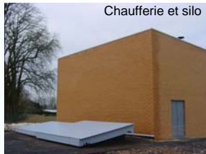
Chaufferie et silo
