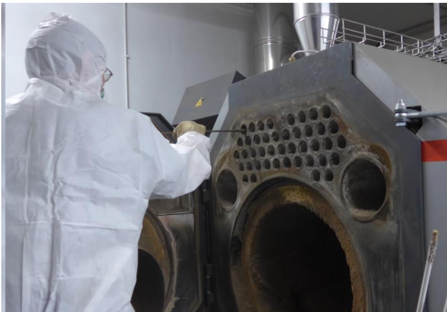
Nettoyage des tubes de l'échangeur de la chaudière
