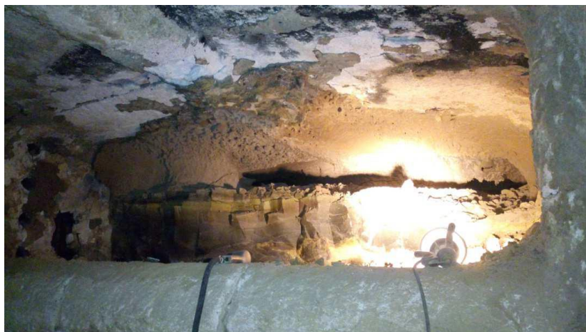
Vitrification – Bois trop sec, trop de particules fines
