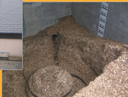
Le silo à plaquettes de bois avec son dessileur rotatif et sa trappe de remplissage intégrée à la toiture de la chaufferie.
