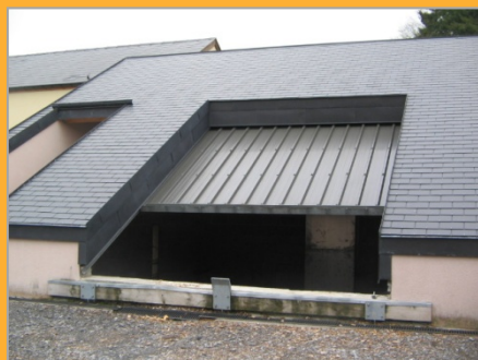
Le silo à plaquettes de bois avec son dessileur rotatif et sa trappe de remplissage intégrée à la toiture de la chaufferie.
