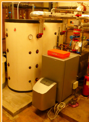
Ballons hydro-accumulateurs, chaudière d'appoint et silo préfabriqué
