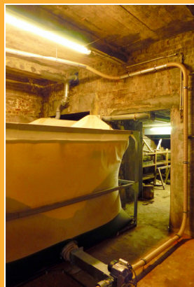
Ballons hydro-accumulateurs, chaudière d'appoint et silo préfabriqué
