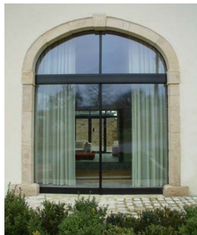
Localisation : Bonnert - ARLON Architectes Urbanistes Valentiny & Associés, Liège
