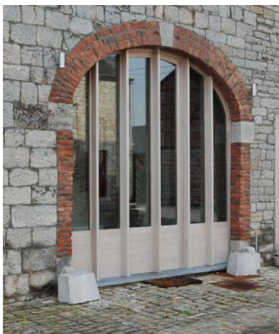
Localisation : Ny - HOTTON L.Tihange, architecte, Marche-en-Famenne
