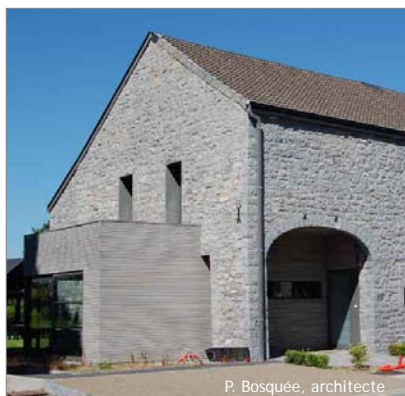
Le contour des deux nouvelles ouvertures de ce pignon est finalisé avec discrétion par un encadrement en acier galvanisé.
