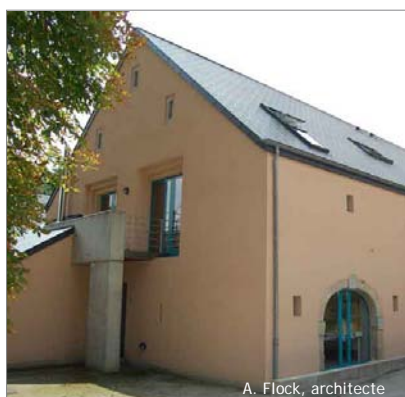
Les encadrements de ces nouvelles ouvertures ont été réalisés en «escalier» dans l'épaisseur du mur et se différencient sobrement des baies traditionnelles de la façade.
