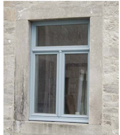
Une division verticale symétrique avec une imposte vitrée en partie supérieure.
