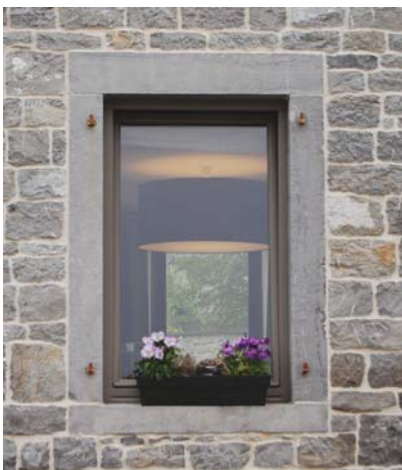
Un châssis sans division, en harmonie de couleur avec le gris du calcaire de la façade.
