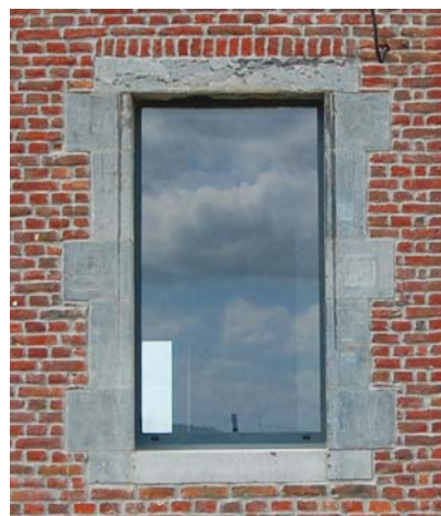
Un châssis peu présent visuellement qui met en évidence l'encadrement en pierre.
