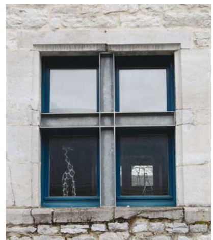
Une division contemporaine en acier qui remplace une croisée de pierre.
