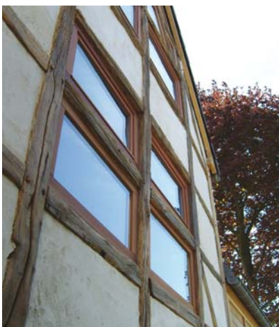
Une menuiserie en bois insérée dans une ancienne structure en colombage.
