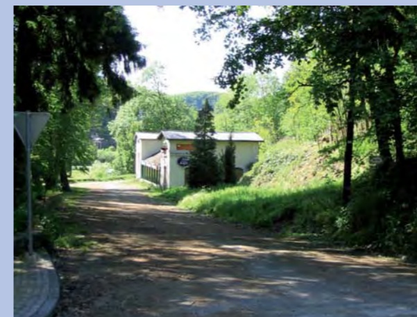
Le site du Maupas avant aménagement : consulter c'est parfois simplifier !
