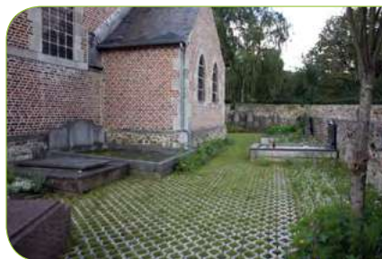
Les dalles alvéolées sont une option qui permet le passage d'engins de chantier légers (Neuville-sous-Huy, Huy).
