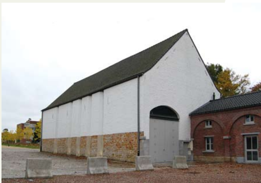
La grange après travaux : une nouvelle dynamique en place. Les arcades sont en cours de réaffectation.
