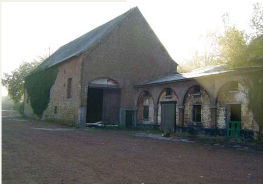
La grange et les arcades avant travaux : un site à l'abandon.
