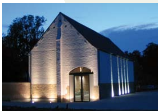
Un éclairage de nuit qui souligne l'intervention sur le bâtiment.
