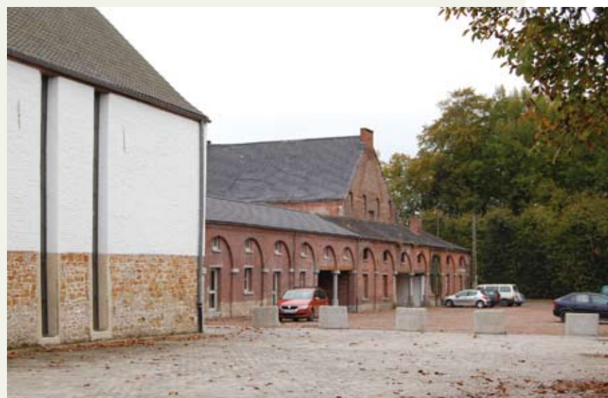
Les sept arcades complémentaires, acquises entre-temps, feront également l'objet de travaux de réhabilitation.
