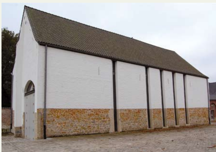
Une maçonnerie de briques badigeonnée en blanc.
