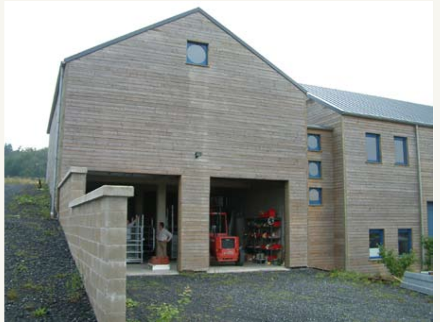
La rampe d'accès et le niveau d'atelier au sous sol
