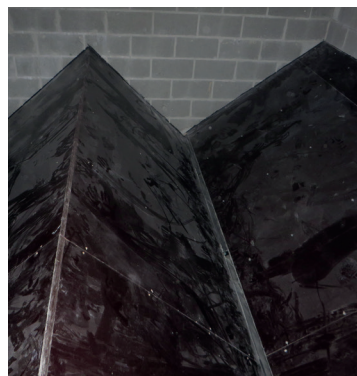
Silo à pellets en W
