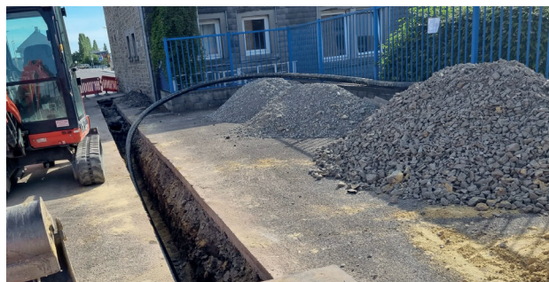
Pose du réseau de chaleur
