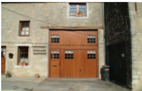
A éviter : un panneau complexe, avec la multiplication de «fenêtres» à l'intérieur du panneau de porte
