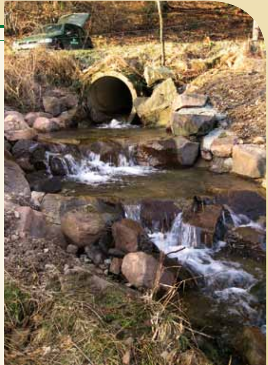
Aménagement de pré-bassins pour résorber le dénivelé aval de la buse.
