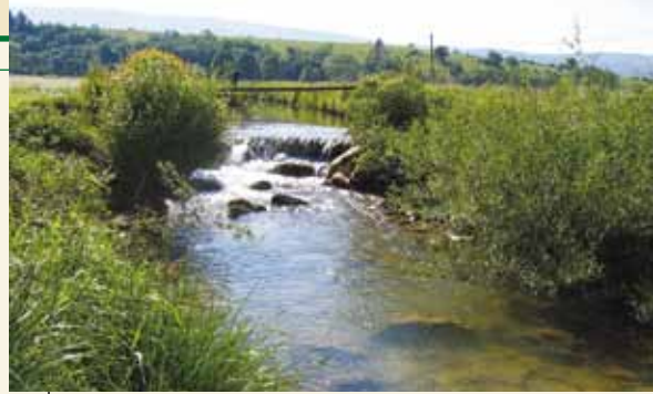
Le seuil forme une chute de 80 cm de hauteur.
