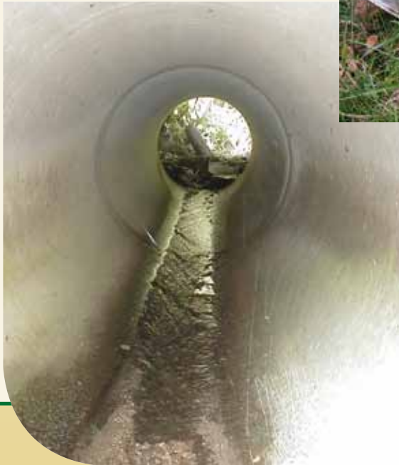
Détail des seuils en acier inoxydable.
