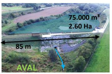
A l'amont, l'ouvrage crée une sur-inondation ou un surstockage par rapport à la situation naturelle. Le volume de surstockage disponible détermine la durée possible du laminage.
